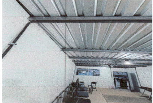
Foto 2. Sustitución de Soporte de Metal por Metal
