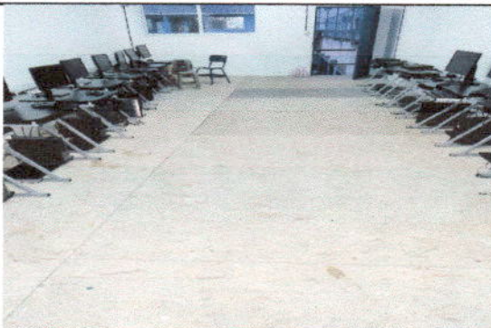
Foto 5. Sustitución de Piso por Piso Madera Enchapada
