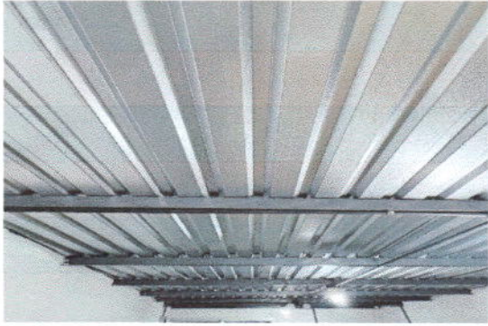
Foto 1. Sustitución de Lamina, por Lamina Troquelada Calibre 26
