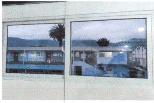
Foto 4. Sustitución de Estructura de Metal de Ventana por PVC mas vidrios
