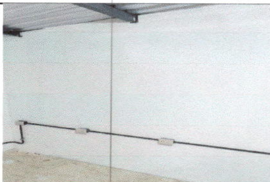
Foto 6. Sustitución de Muro de Playwood por Muro Prefabricado con pintura.
